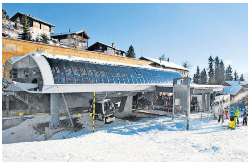
Beförderung. Die neue Talstation wurde teilweise in die alte integriert. Neu können stündlich 2400 Personen transportiert werden (gegenüber 2200 vorher).
