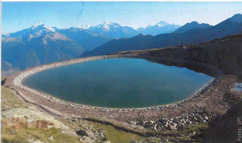
Der Speichersee Blatten für die Belalp Bahnen AG wurde von der Schmidhalter & Pfammatter Ingenieure AG geplant.
