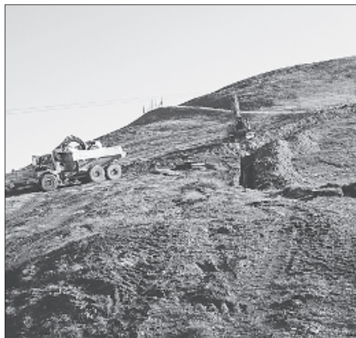
Das Leitungssystem verbindet 40 Beschneigungsschächte. Ihre Einsätze können vollautomatisch gesteuert werden.
