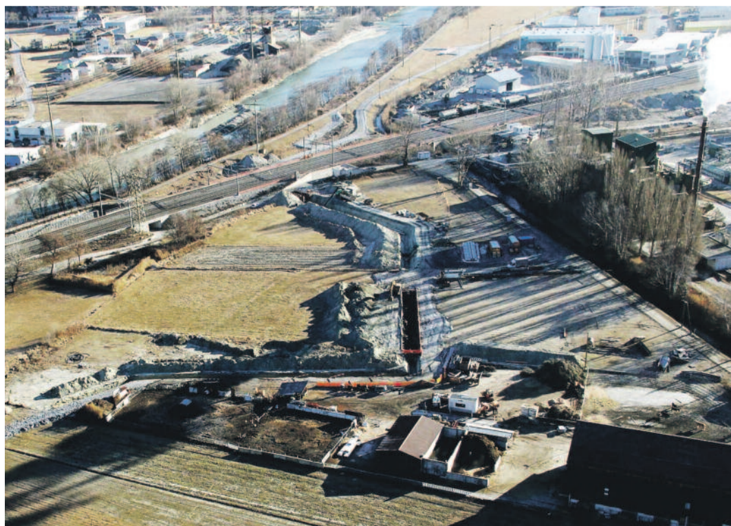
Vorarbeiten. Bevor der Vollanschluss erstellt werden kann, müssen zuerst verschiedene Leitungen und Kanalisations verschoben werden. Die neuen Schächte sind schon ausgehoben.
