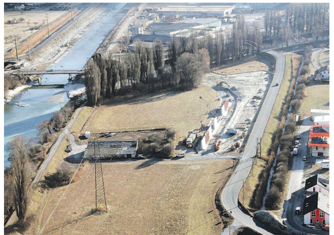
Linienführung ersichtlich. In der Wehreya werden derzeit Schutzwände erstellt, um die Autobahn vor Hochwassern zu schützen. Das Trasse hin zur neuen Brücke über die Vispa ist bereits erkennbar.
