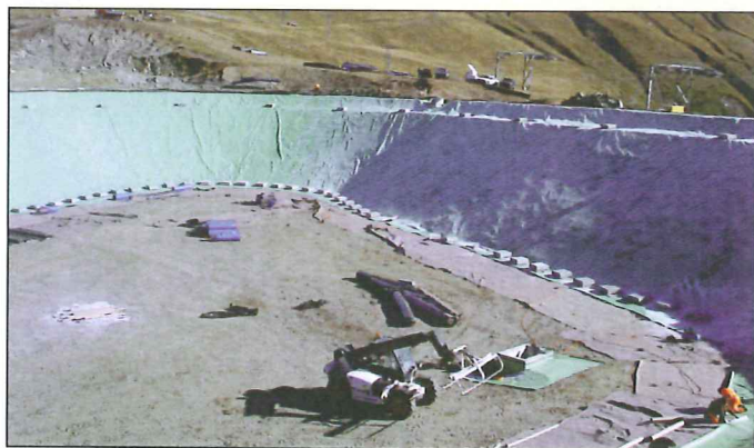
Zur Abdichtung wurden u. a. 10.000 m 2 Abdichtungsfolie (Sarnafil MP G 970-25, flexible Polyolefine mit Glasvlies-Einlage, 2,5 mm) eingesetzt Fotos: SPI
